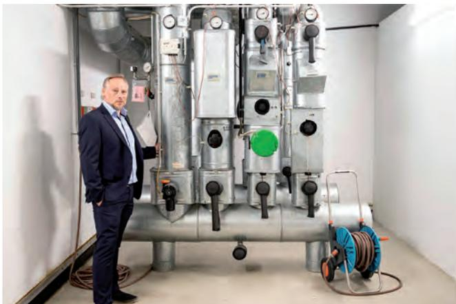
Herr Hage vor dem Kaltwasserverteiler, der bisher die Lüftungsanlagen der IHK versorgt (Foto: Salome Roessler Lens and Light)
